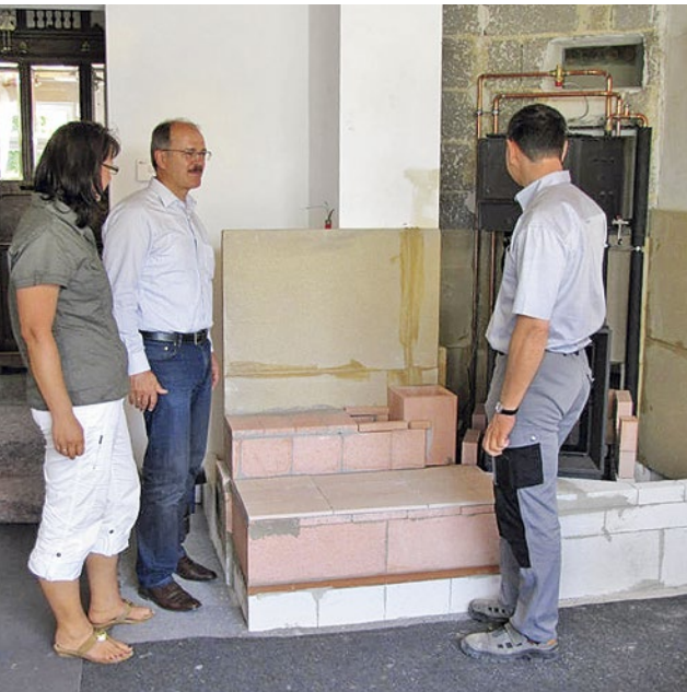
Kontakt mit Menschen: Wichtige Bauabschnitte werden besprochen, die Bauherren aktiv mit einbezogen.
